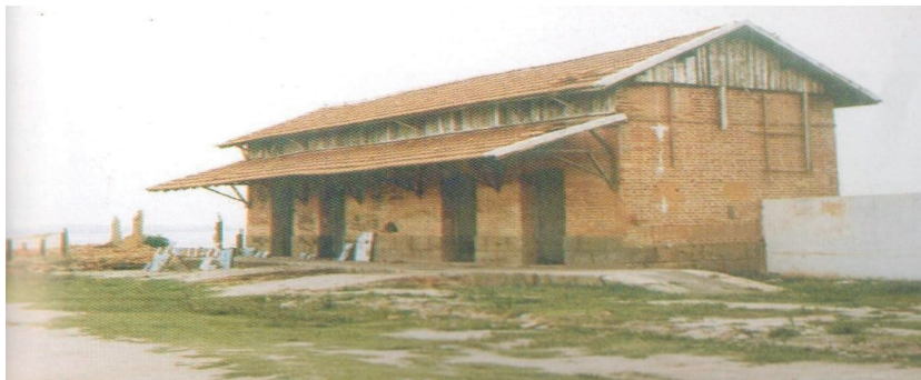
Figura 10 - Estação de Ferro Barão de Mauá: atividade IPABH. Fonte: LACERDA; TORRES (2004, p. 105).
